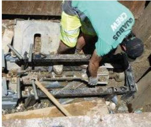
**Berst-Verfahren, Aufweitkopf wird demontiert**
