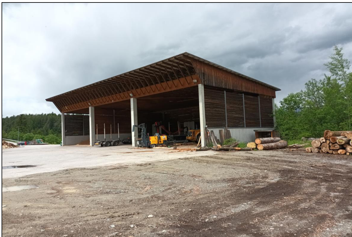
Foto 3 - Blick auf das Betriebsgebäude der Fa. Moser Transporte GmbH von Südosten
